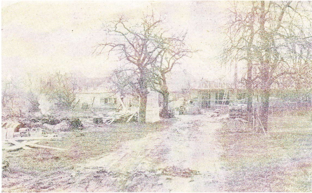
Op een particulier erf aan de Perenstraat is één bouwer al aan de slag.
