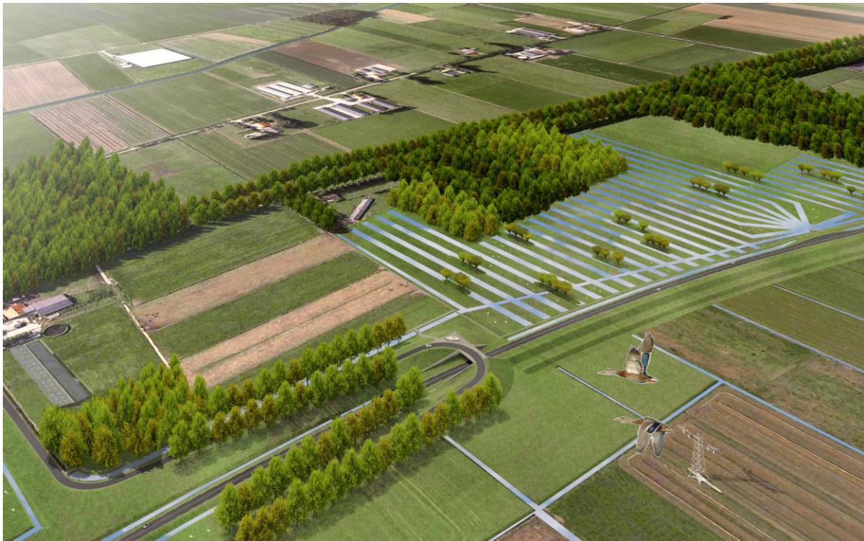
Overzicht viaduct Geerstraat + waterberging
